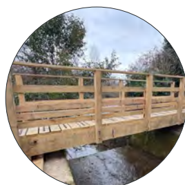
Création de passerelles piétonnes
