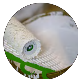
Travaux de bâtiment (peinture, maçonnerie...)
