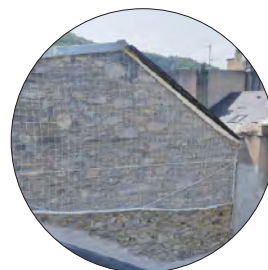
Pose de filets de sécurité
