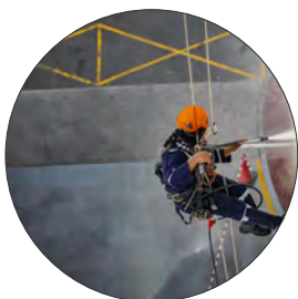
Nettoyage & rénovation de façades
