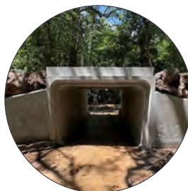
Réalisation d'ouvrages béton
